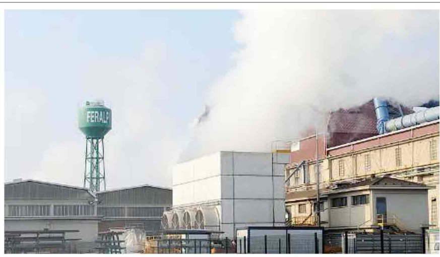
L'industria. Gli impianti della Feralpi con la caratteristica nube di vapore acqueo
